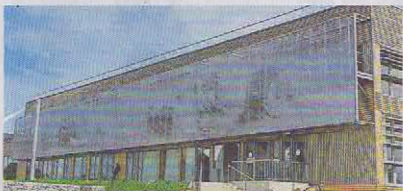
La façade du lycée professionnel maritime Florence-Arthaud, à Saint-Malo.
